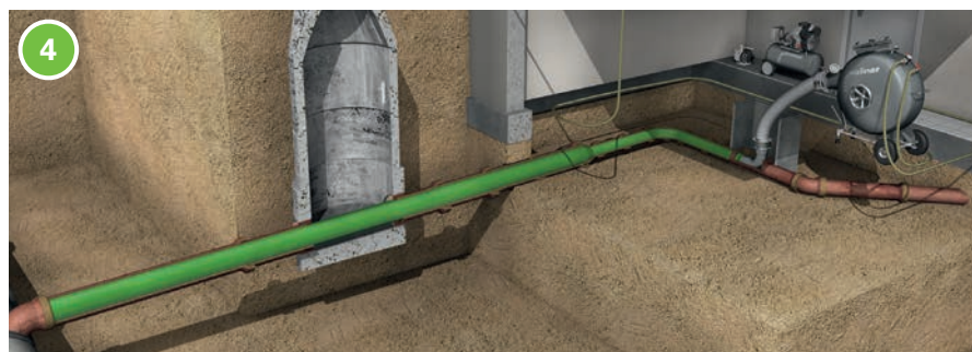
4 Nach dem Aushärten ist ein neues Rohr im Altrohr entstanden
