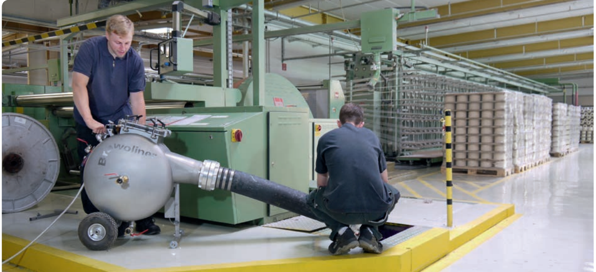
BRAWOLINER®-Sanierung während des Produktionsbetriebs
